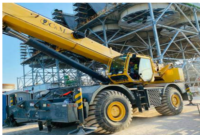
• GRÚA GROVE • 148 ft • 56 ft Aguilon •
